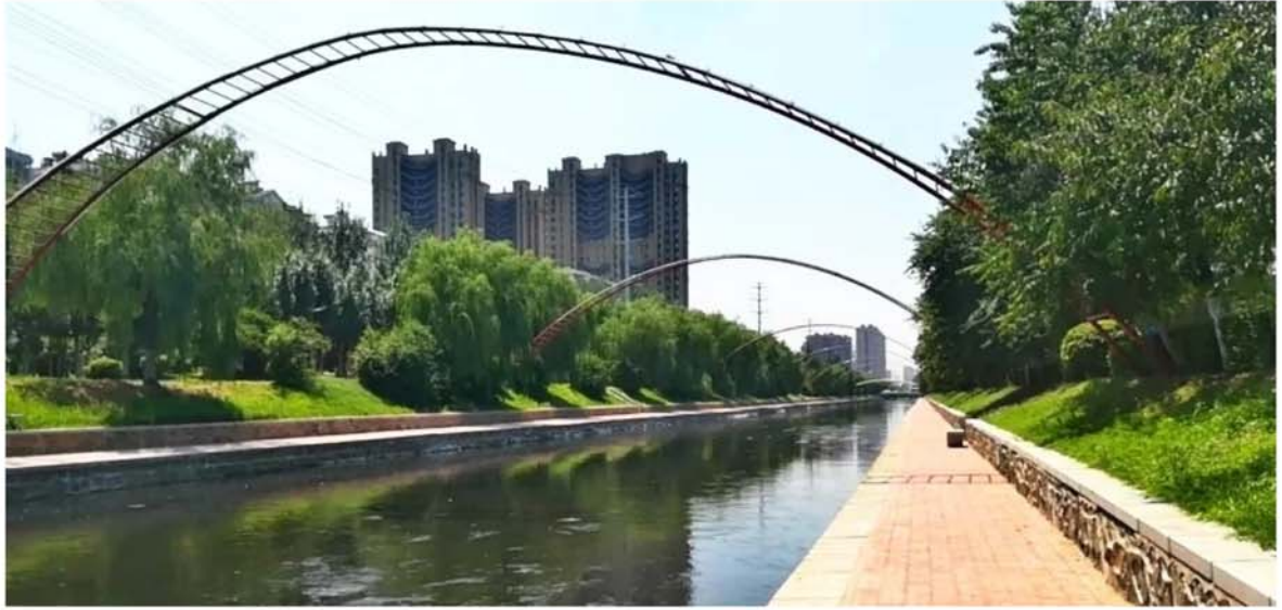
卫工明渠护岸维修与人行铺装恢复
